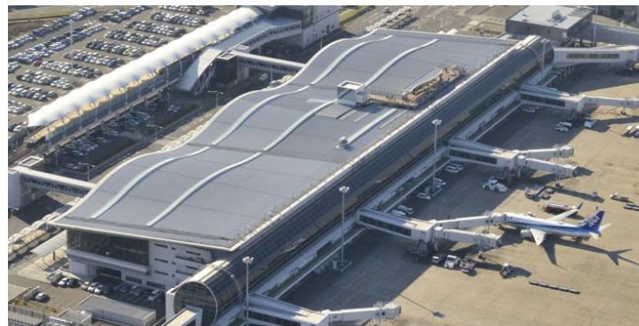
旅客ターミナルビル大屋根・鉄骨塗装工事（イメージ）
