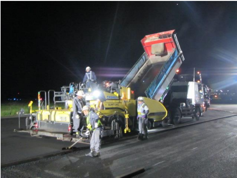
※滑走路及び誘導路舗装補修工事。
