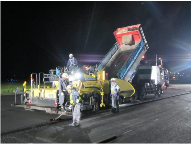
※滑走路及び誘導路舗装補修工事。
