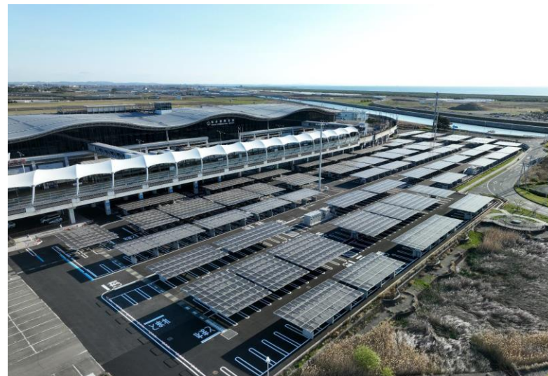
ソーラーカーポート新設工事
