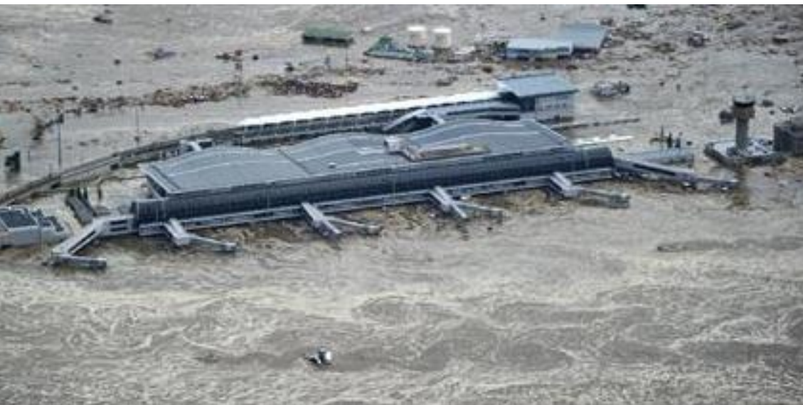
▲津波により被災する仙台空港
